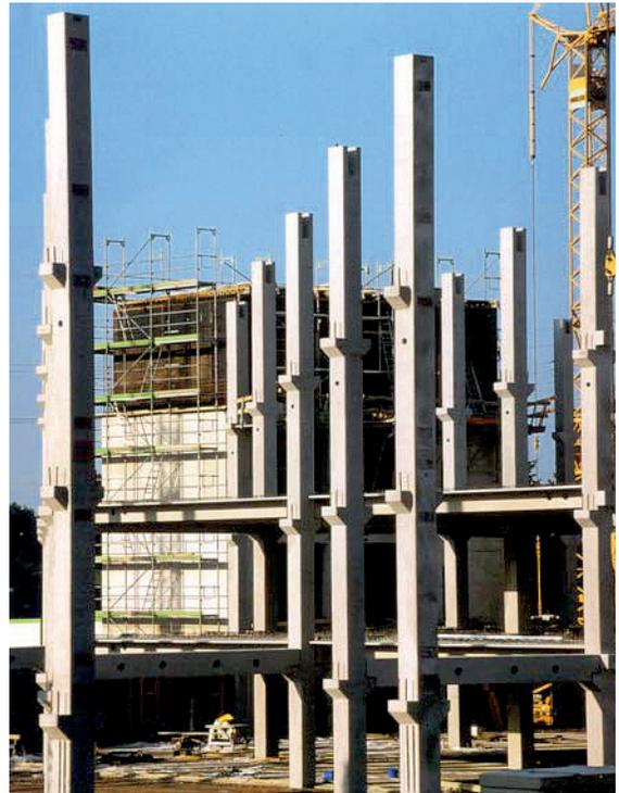
Bild 1: Fertigteilkonstruktion mit Konsolen
